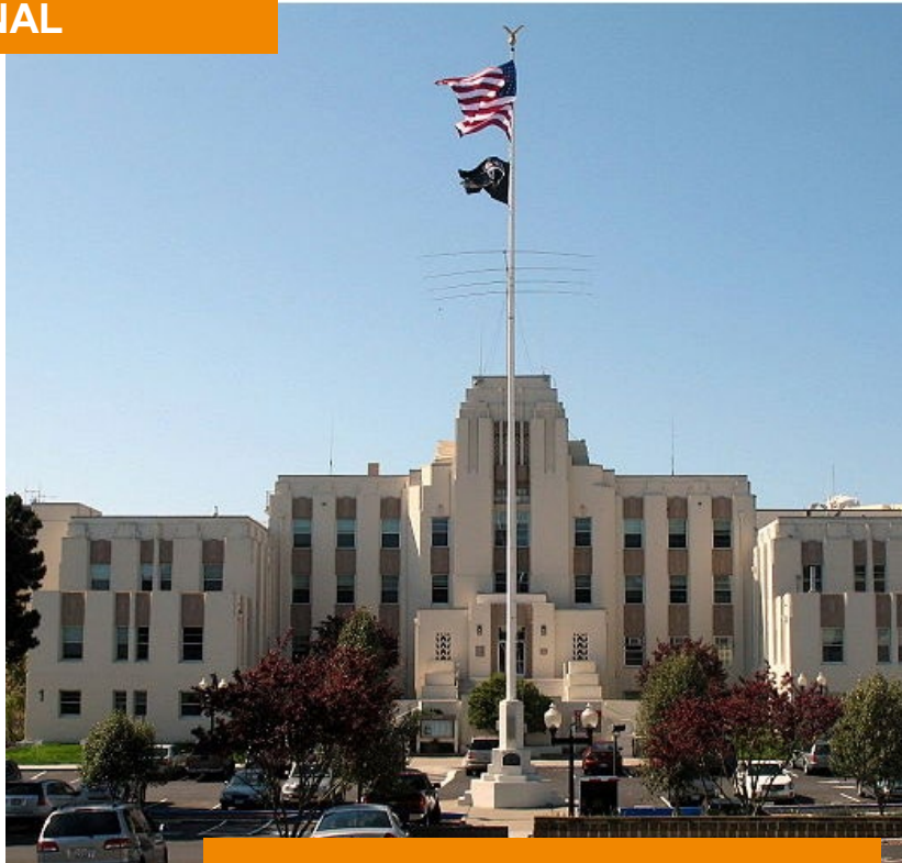
Fachada posterior del VA Medical Centre
